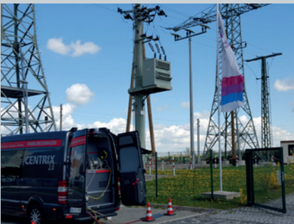
Vérification et diagnostic des câbles
