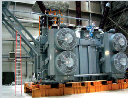
Mesure des décharges partielles
