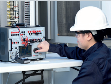
Vérification des relais de protection
