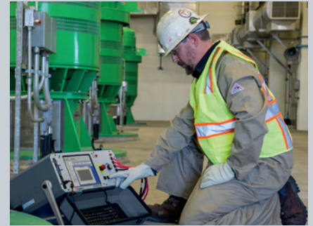
Vérification des moteurs et des générateurs
