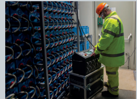
Vérification des batteries
