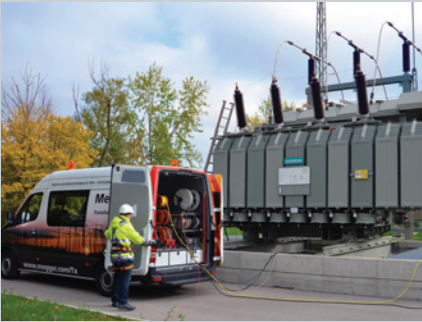
Évaluation du cycle de vie des transformateurs
