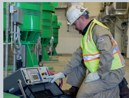
Pomiary silników elektrycznych i generatorów
